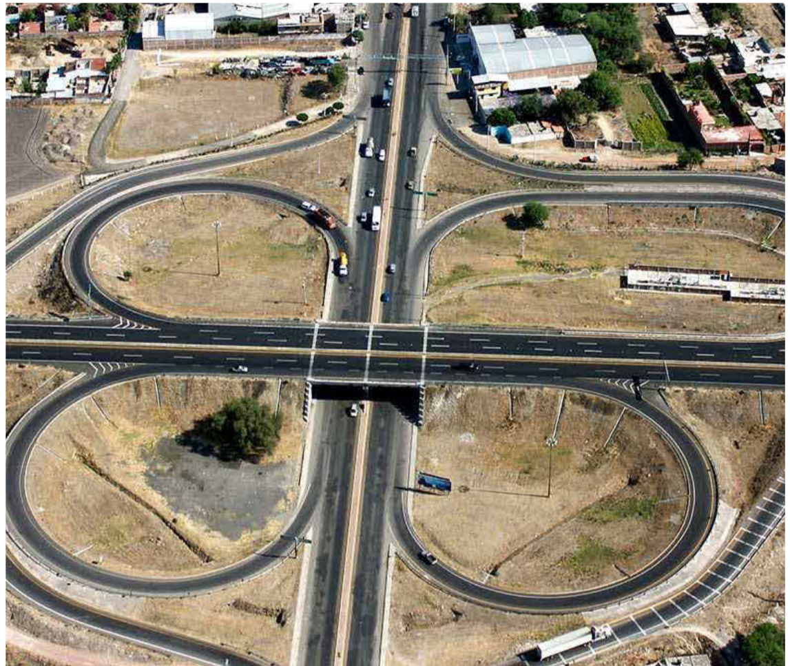
Imatge d'arxiu de les autopistes Libramiento Sur i Nororient de Celaya, a Mèxic, obres de Rubau.
